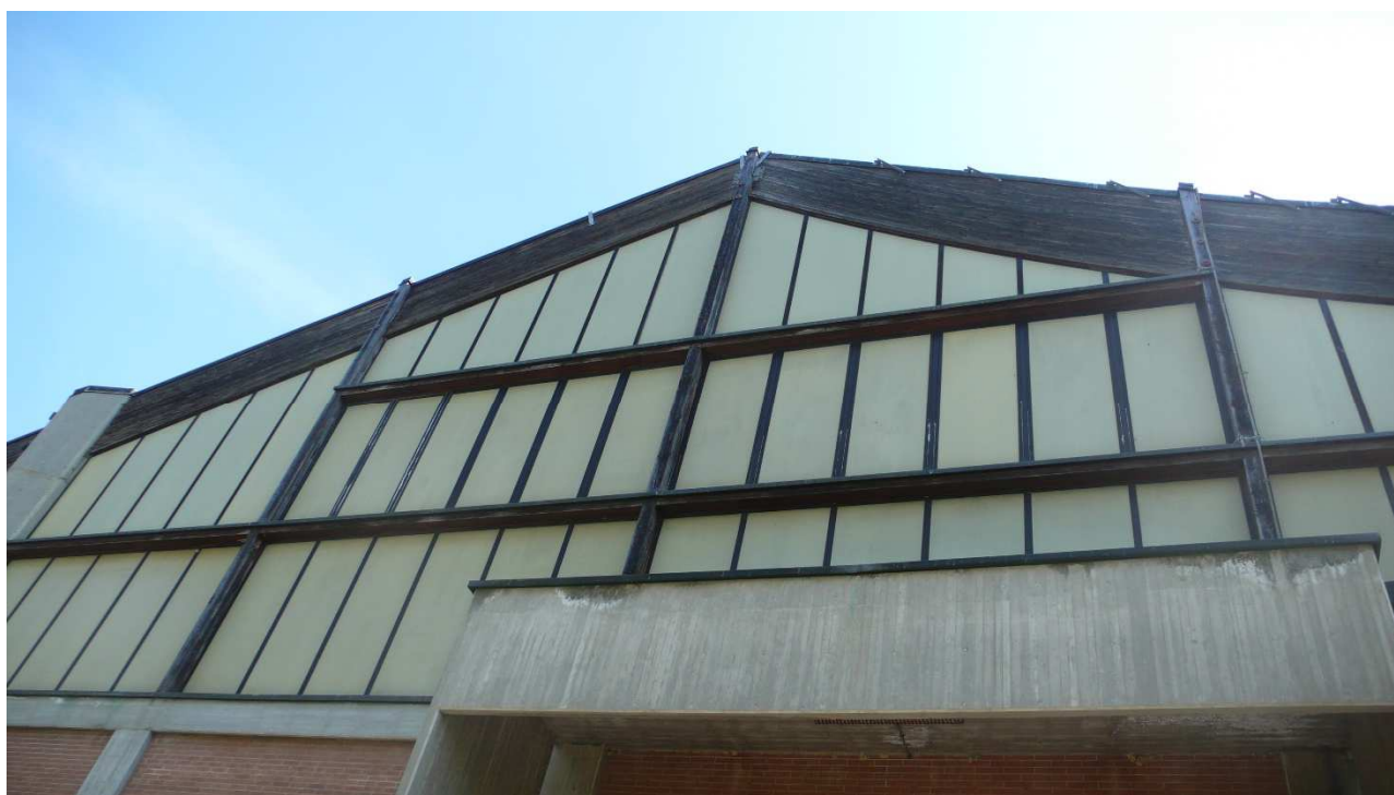
Figura 2 - Sistema di facciata a montanti e traversi in legno
